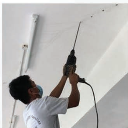
PU Injection Grouting
